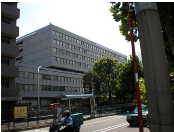
写真-10 軸耐力補強で安全確保した総務省統計局
