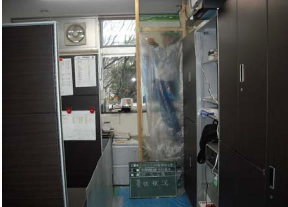
写真-9 大学研究室内の補強工事状況
