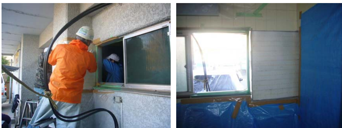
写真2-3 短柱の包帯補強工事
