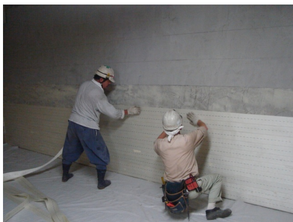
SRF 工法壁補強工事
