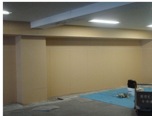
SRF 工法壁補強工事
