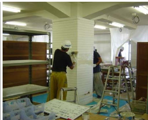
写真 2 補強工事の様様 (大学校舎)
