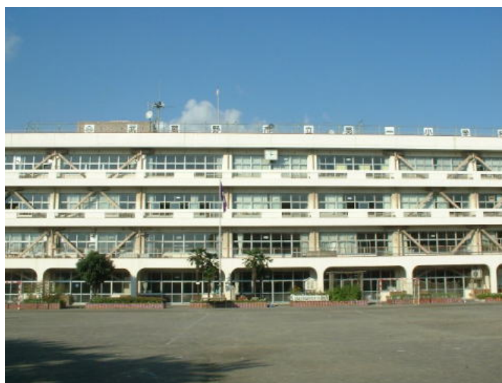
写真4 従来補強の例（変形すると柱が破壊し、倒壊するので変形を抑える）
