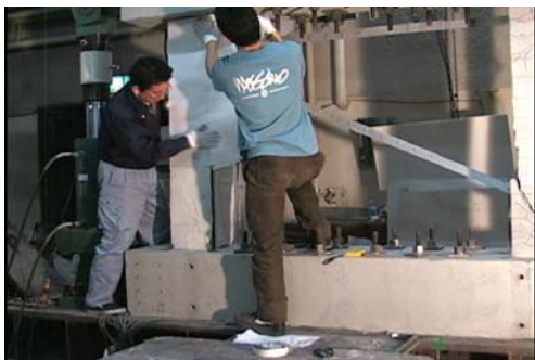
応急補強（北側柱：SRF200）
