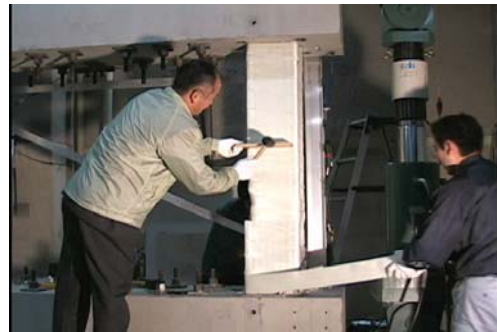
応急補強（南側柱：SRF2100）
